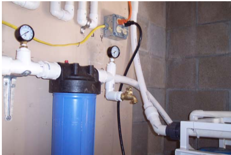
Ilustración 7.6-2 Conexión en cruz en el módulo del descalcificador para una válvula para muestras.
