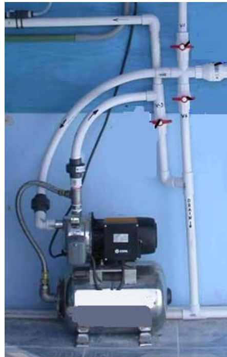
Ilustración 7.3.3-2 Alternativa de la bomba para pozo llano
