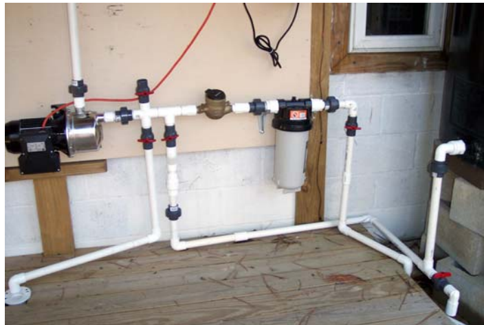
Ilustración 7.3.1-1 Entrada de agua sin tratar a un tanque sobre el terreno.
